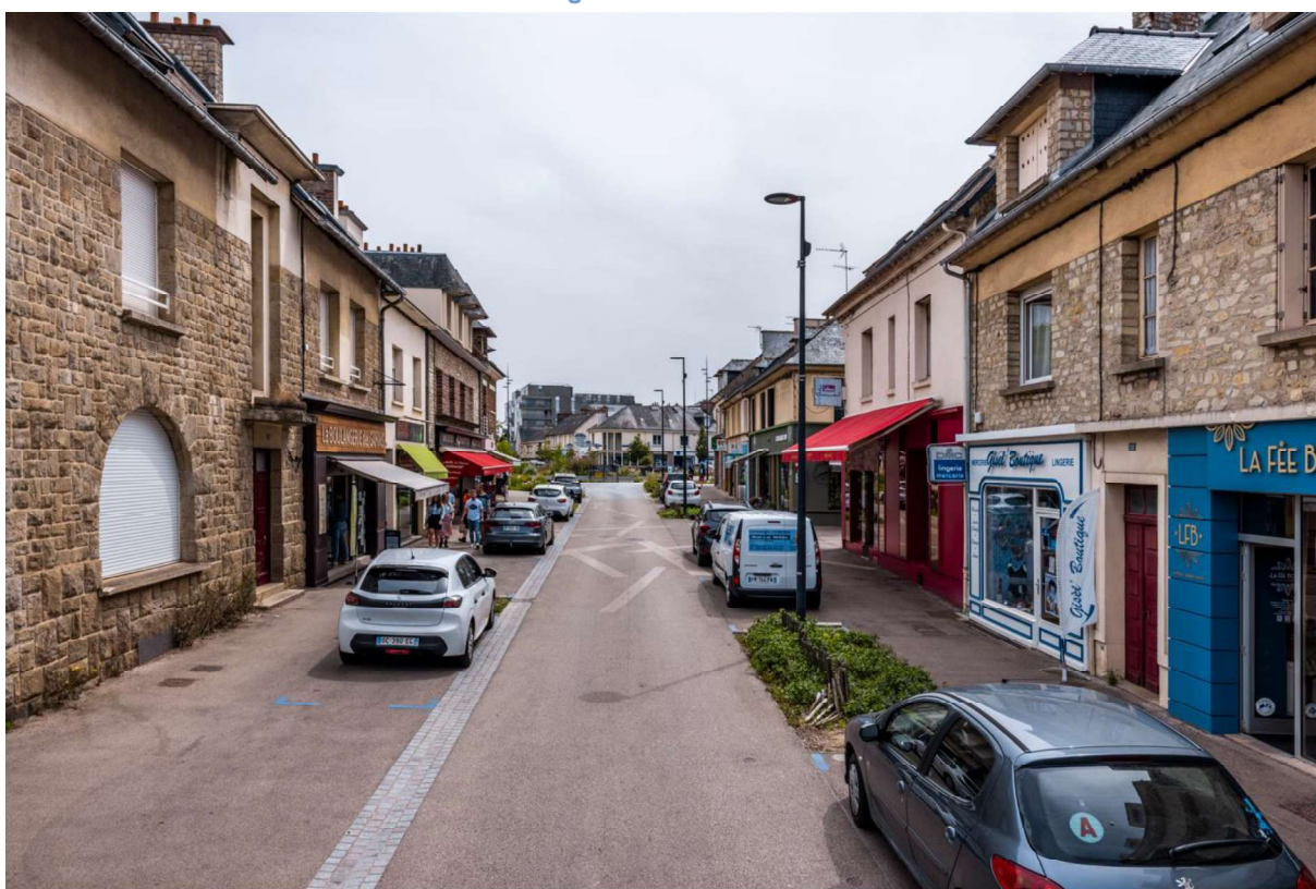
Avenue Joseph Jan, état existant
